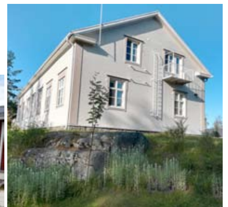
Tohniin koulu valmistui 1935. Toimii nyt Tohniinmäen Talon päärakennuksena.
